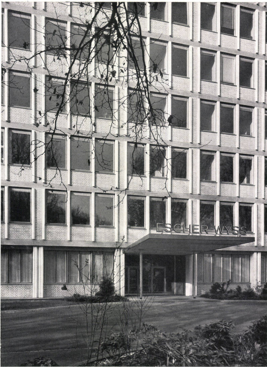
1 Teilansicht der Eingangsfront mit den Büros. Vue partielle de la façade de l'entrée avec les bureaux. Part view of the entrance facade with the offices.
