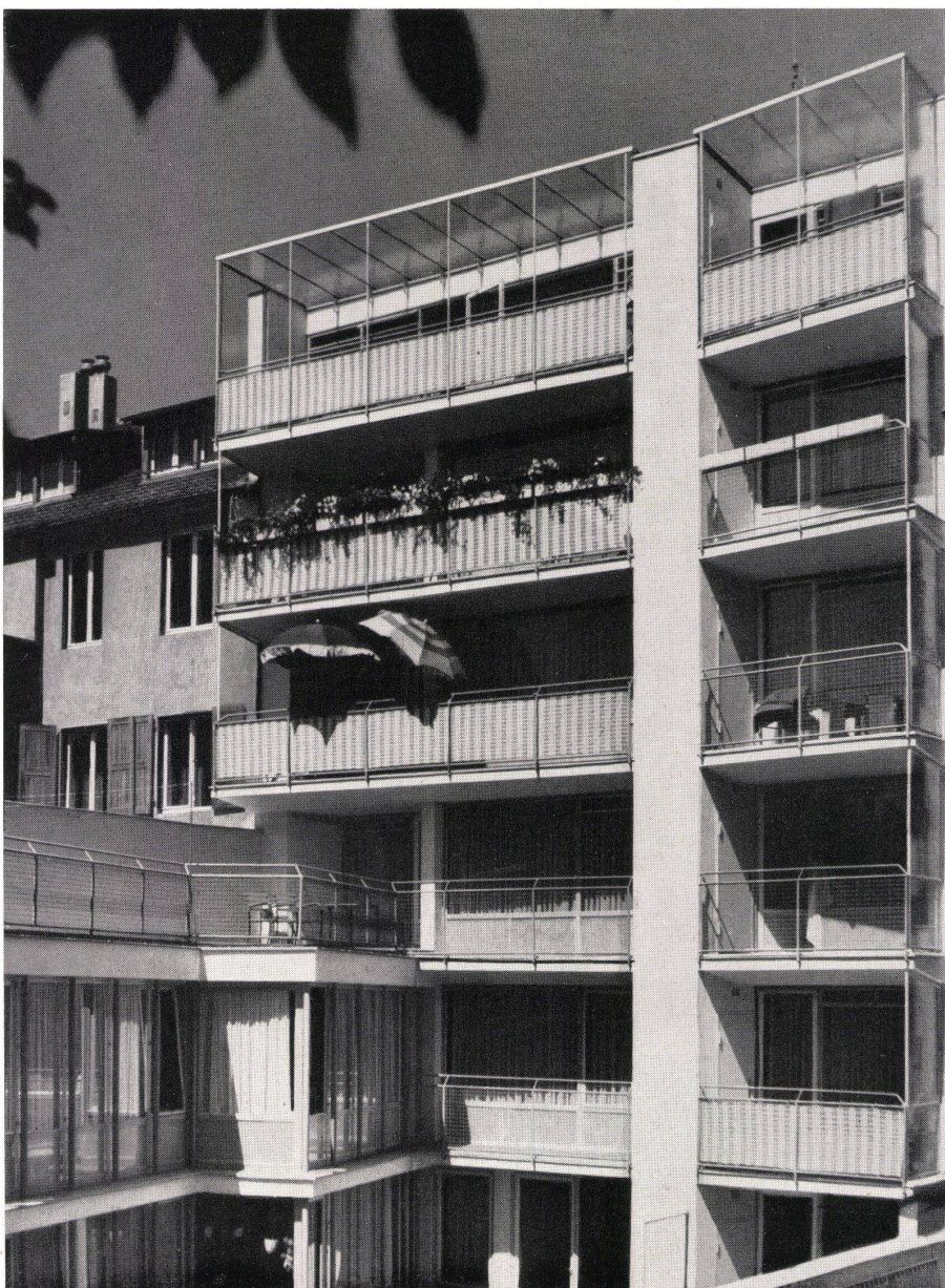
1 Detailaufnahme des Gartenzuganges im Erdgeschoß. Stahlteile: blau. Brüstungen: Gußglas. Nur die Türen und Lüftungsflügel sind beweglich. Die großen Scheiben sind feststehend. Die Speisekammern liegen außerhalb der Wohnungen und sind vom Balkon aus zugänglich.
