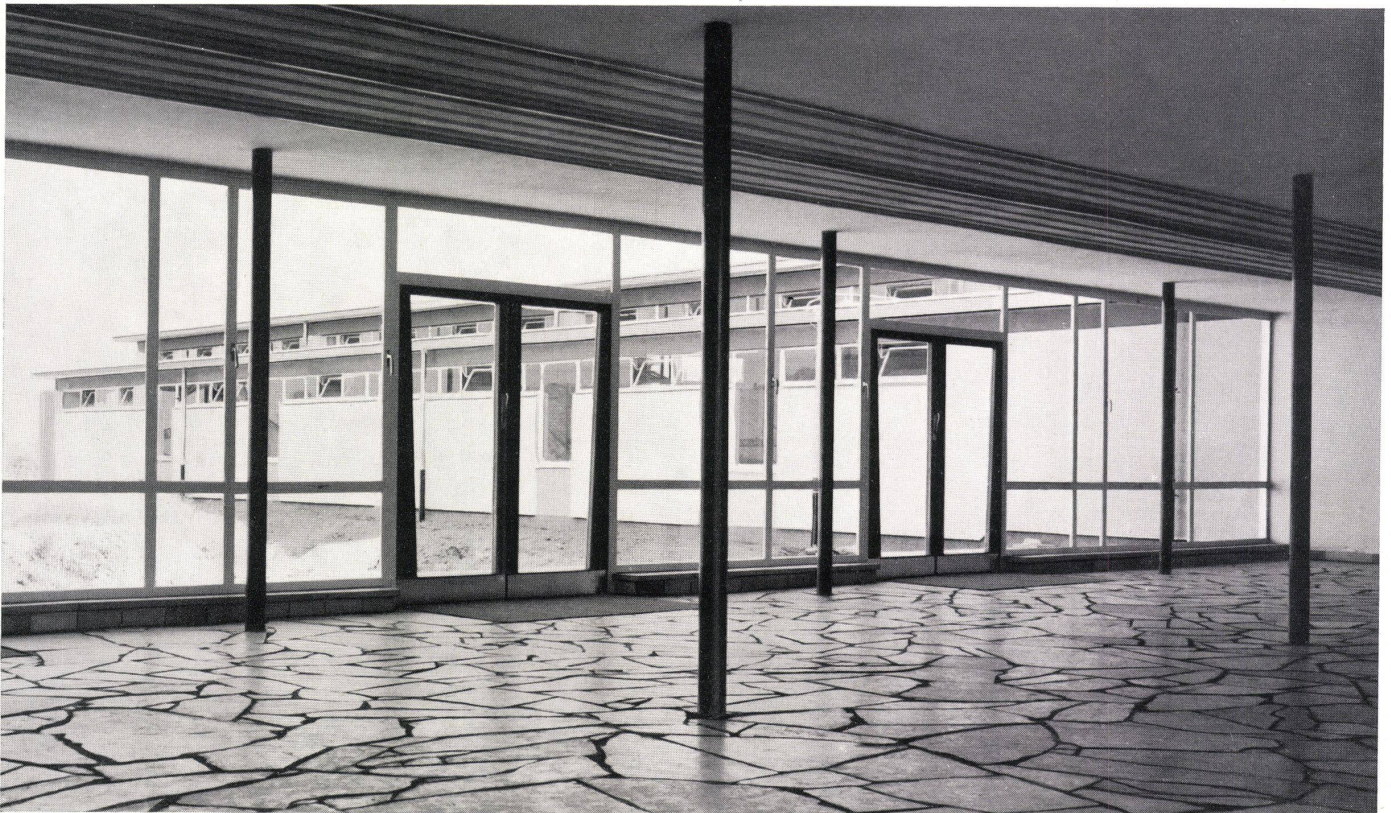
Pausenhalle mit Blick auf den Ostflügel der Schule. Hall des récréations avec vue de l'aile est de l'école. Recreation hall and view of east wing of school.
