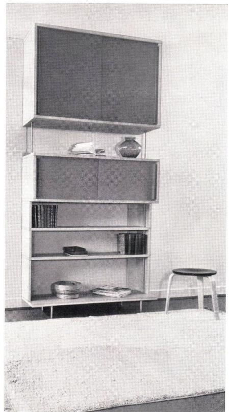
Zusammenbau von Brett-, Tablar- und Türelementen zu einer vertikalen Wandkombination. Die Verwendung der Stahlstangen erlaubt eine praktisch unbegrenzte Erweiterbarkeit in der Höhe.
