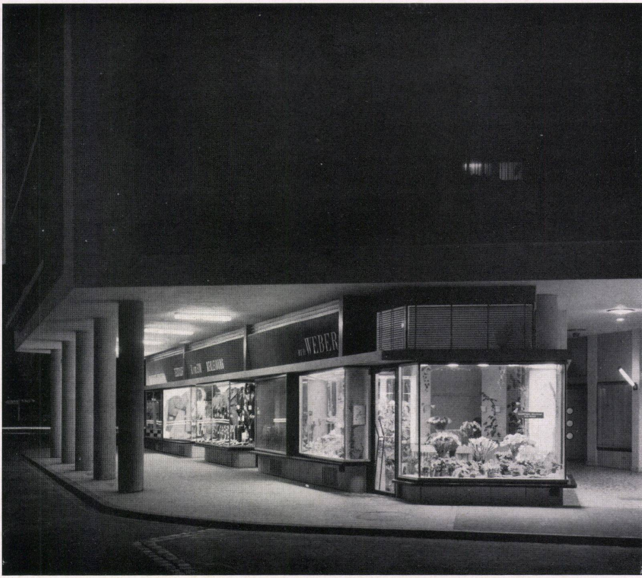
Nachtaufnahme mit den Läden. Vue de nuit de l'immeuble et des magasins. View by night, with the shops.
