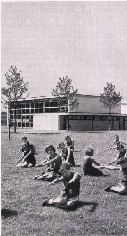
Ansicht der Turnhallen von Nordosten, davor die eingeschossigen Turngarderoben. Les salles de gymnastique vues du nord. North view of gymnasium.
