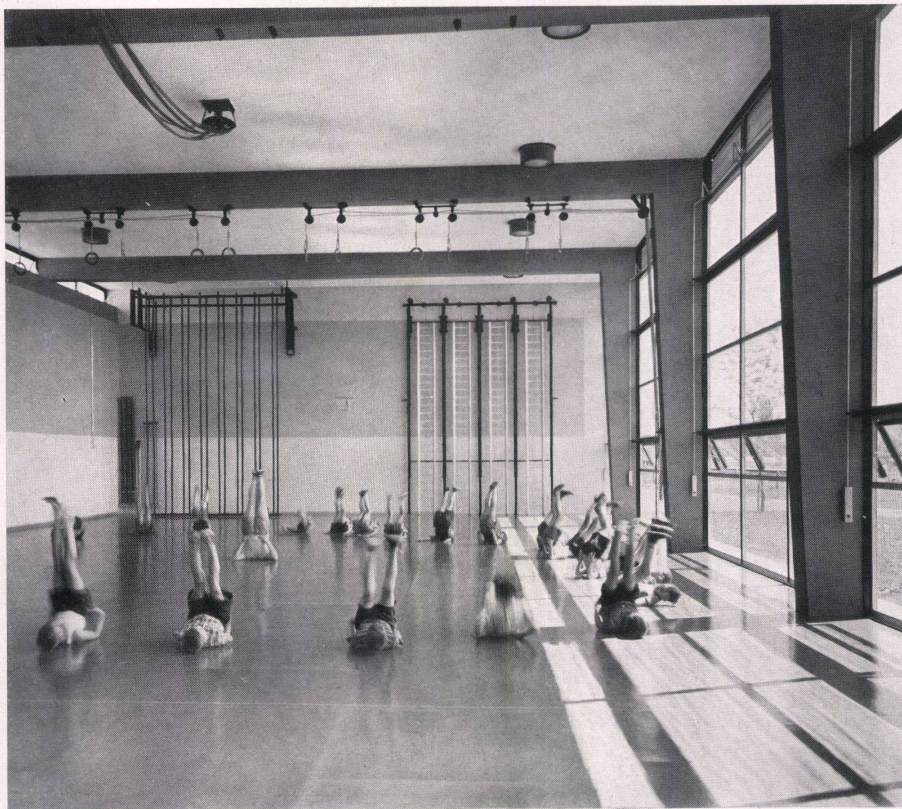
Inneres der Turnhalle. Unterzüge und Pfeiler Sichtbeton, grau-schwarz gestrichen; Wände verputzt, weiß; darüber Akustikplatten, hellgrau; Stramax-Deckenheizung weiß; Boden Korklinoleum, naturfarbig; Fenster mit Aluminiumprofilen, naturfarbig eloxiert. Vue intérieure de la salle de gymnastique. Interior of gymnasium.
