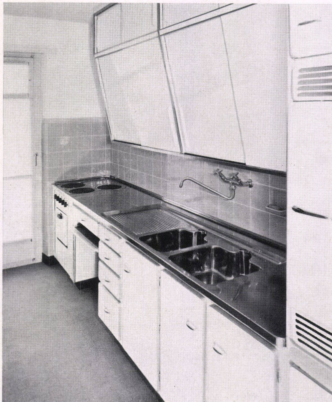
Franke-Einfrontküche. Hier dominiert der Spültisch mit zwei Becken in Frei-Ventil und der rechterhand in Kopfhöhe eingebaute Kühlschrank. Vom Rüstplatz aus – zwischen Herd, Schubladenschrank und Spültisch – läßt sich griffnah hantieren. Unter dem Oberbau sind Platzleuchten installiert.
