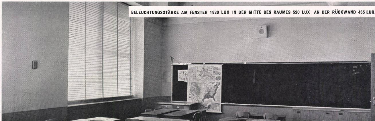
BELEUCHTUNGSSTÄRKE AM FENSTER 1830 LUX IN DER MITTE DES RAUMES 520 LUX AN DER RÜCKWAND 465 LUX
