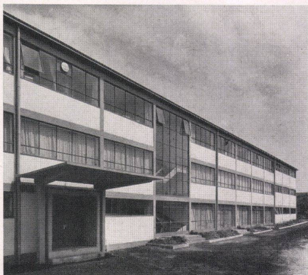
Rückseitige Ansicht mit dem Treppenhaus. Im Erdgeschoß die Buchbinderei, im Obergeschoß Linotypie, Monotaster, Stereotypie und Wasch- und Umkleideräume für Männer. Vue de la façade arrière et de la cage d'escalier. Back view with staircase wall.
