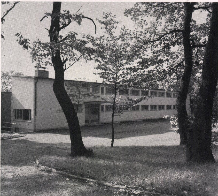
Eingangsseite (Nordfassade). Côté entrée (façade nord). Entrance side (north elevation).
