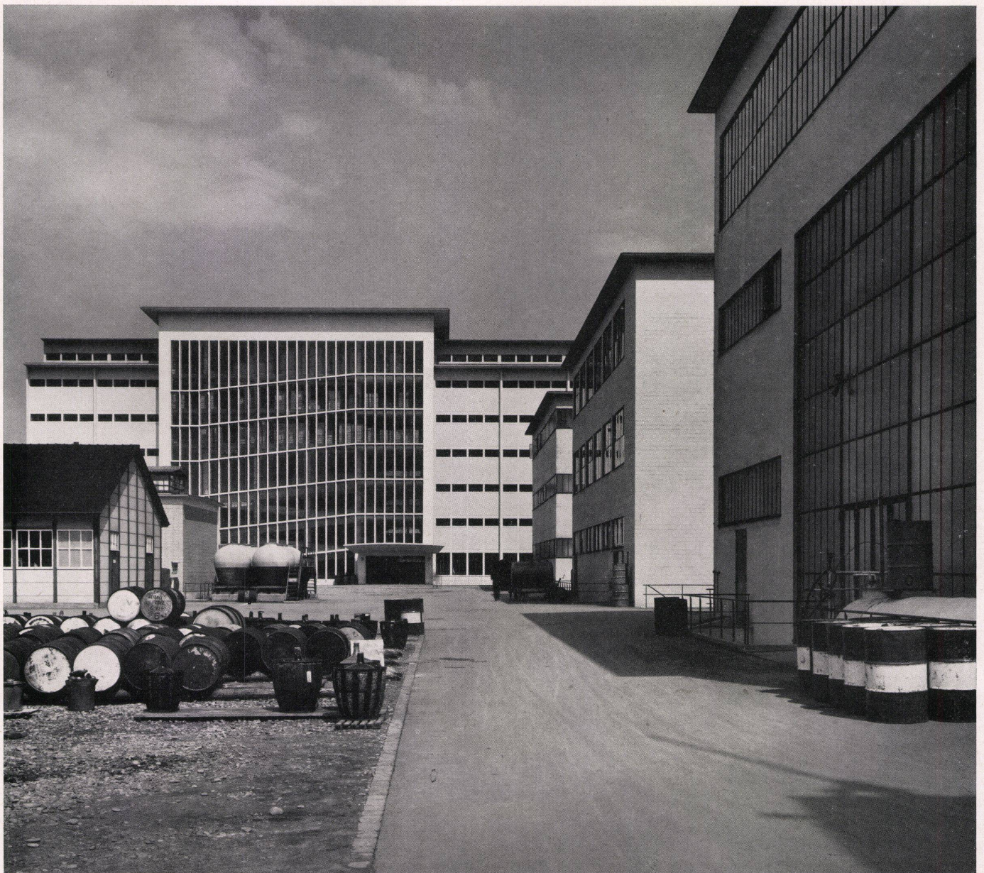
Blick auf den Lagerhausneubau, Bau 41. Vue du nouvel entrepôt. View of the new storage building.
