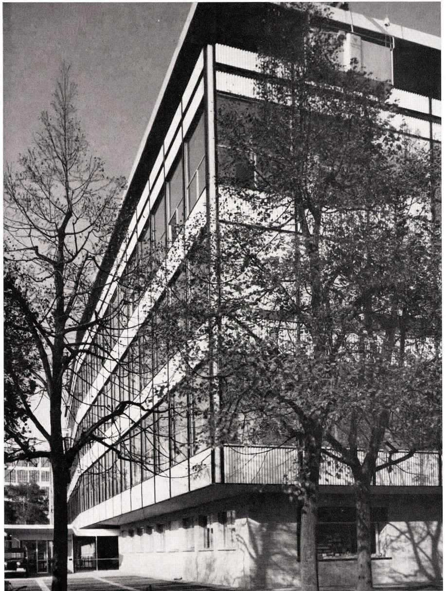
Eckansicht. Vue d'un coin. Corner view.
