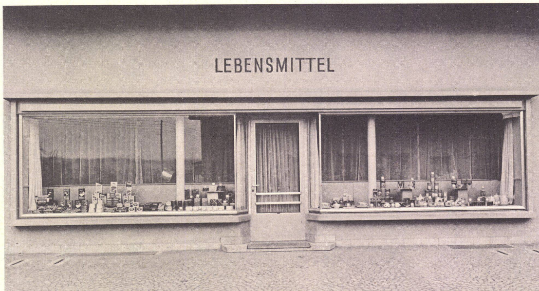
Schaufensteranlage mit Kellpax-Elementen und Kellpax-Leichtmetalltüre sowie Storenkasten eines Lebensmittelgeschäftes.
