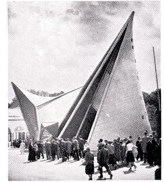
11 Der vollendete Pavillon, von der Eingangsseite her gesehen
