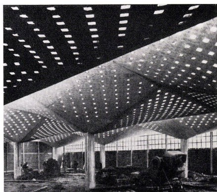
32 Felix Candela, Lagerhaus in Mexiko 1954. Entrepôt à Mexico 1954. Warehouse in Mexico 1954.
