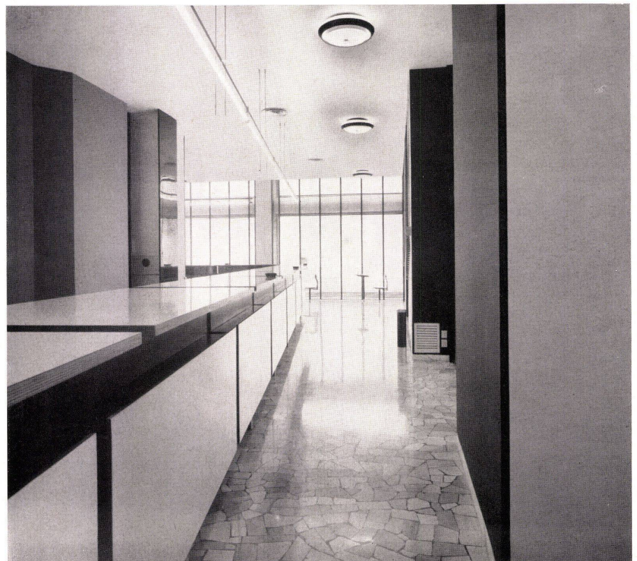
2 Blick vom Eingangsvorplatz in den Schalterraum. Die Luftkanäle sind hinter den Fassadenpfeilern eingerichtet (Ab-luftgitter). Vue du vestibule de l'entrée sur les guichets. Les canaux de ventilation sont aménagés derrière les piliers de façade (grille de ventilation). View from the vestibule on to the counters. The ventilation channels are fitted behind the elevation pillars (ventilation grill).
