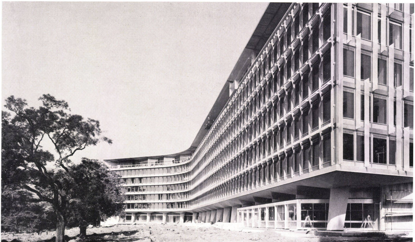
5 Gesamtansicht der Fassade mit Sonnenschutz (Süd- und Ostfassaden). Vue d'ensemble de la façade avec brise-soleil (sud et est). General view of the elevation with sunbreak (south and east elevation).
