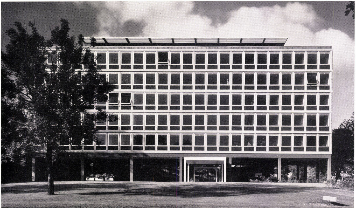
Die Eingangsfassade auf der Nordostseite. Façade de l'entrée du côté nord-est. Entrance elevation on the northwest.
