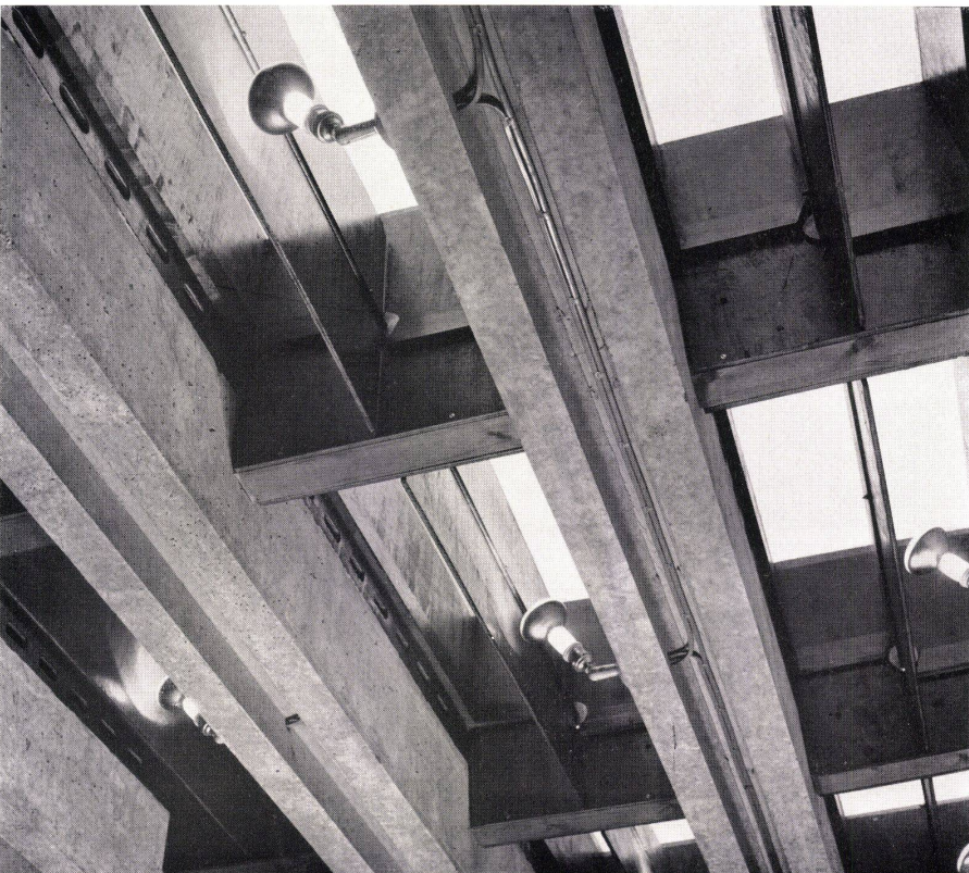
2 und 3 Ausschnitte von der Decke über dem Hörsaal. Parties du plafond au-dessus de l'auditoire. Details of the roof lights above the lecture room.
