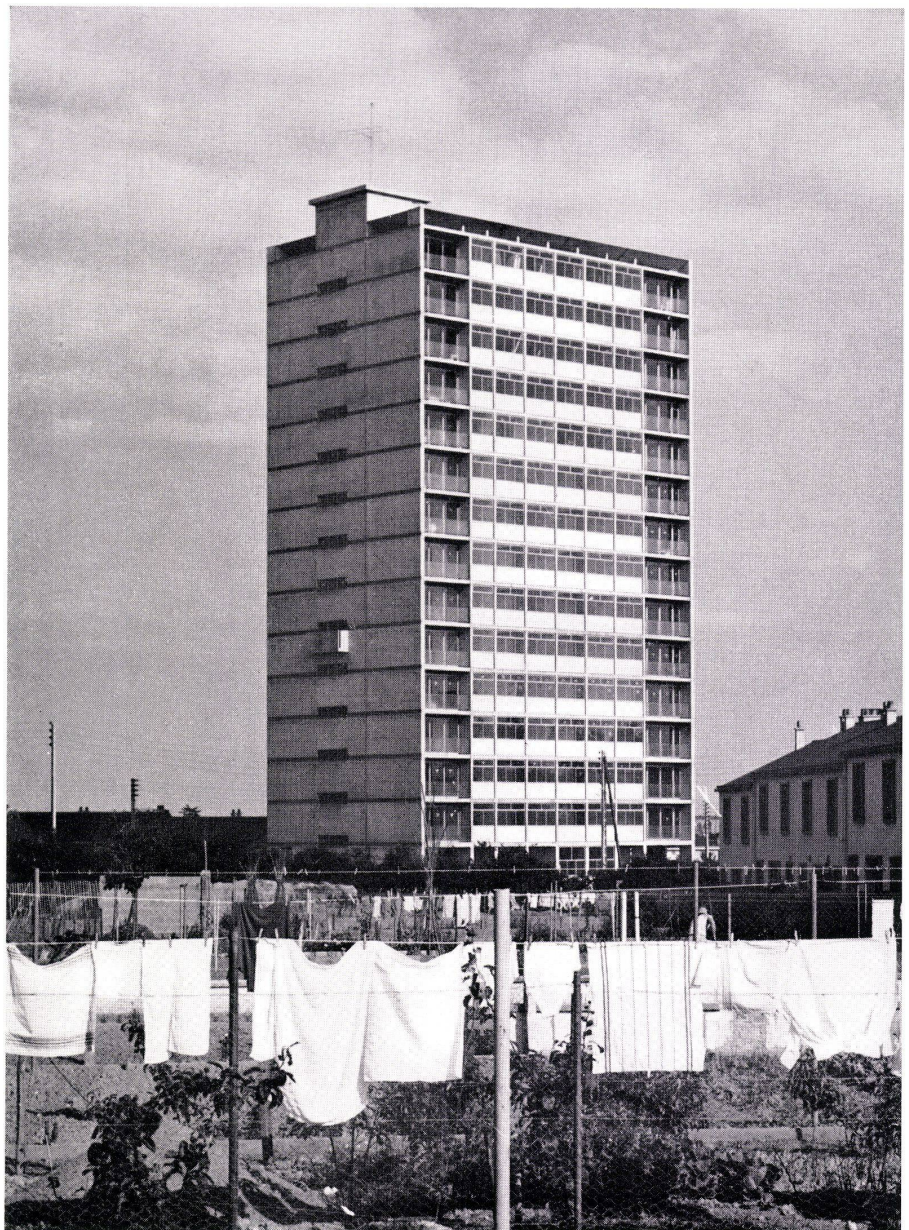
3 Ausschnitt der Süd- und der Ostfassade mit der Eingangspartie. Partie des façades sud et est avec entrée. Part of the south and the east elevation with entrance.
