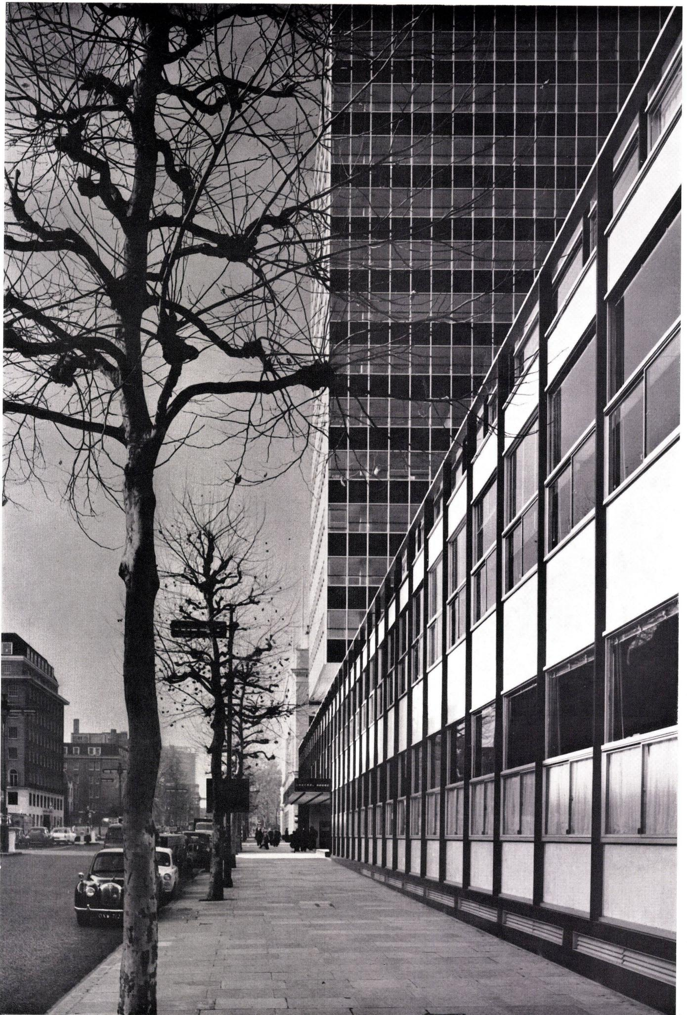
1 Ausschnitt aus der Marylebone Road mit dem Haupteingang im Hintergrund. Die Brüstungen des zweigeschossigen niedrigen Bauteils bestehen aus weißem sizilianischem Granit. Die Fensterelemente sind hier 2,33 m und beim Hochhaus 1,17 m breit, die Brüstungen sind dort mit Calorex-Glas verkleidet.
