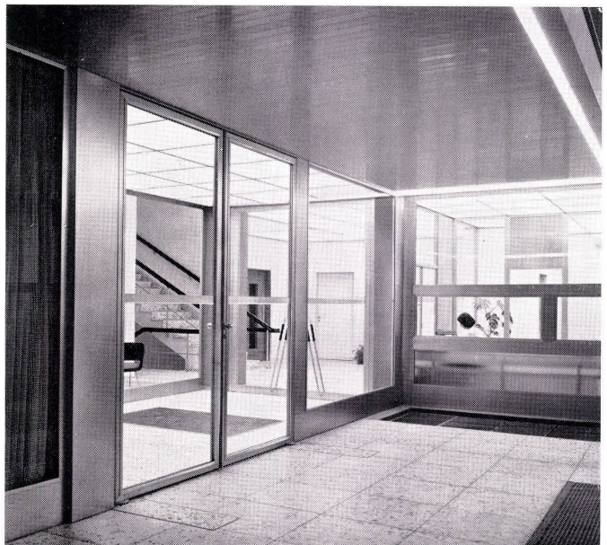
Eingangspartie mit Vordach. Vordachuntersicht mit Wandverkleidungsprofilen.
