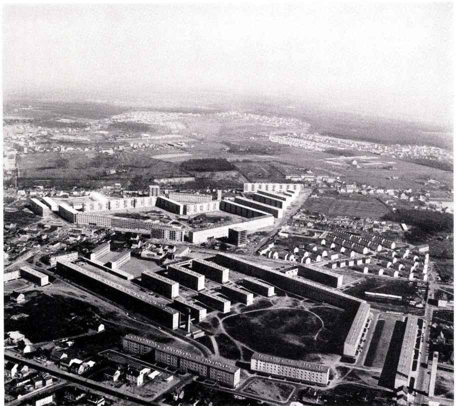
Wiederaufbau eines Wohnquartiers in Arles (oben) und Wohnstadt bei Mans (unten) von Pierre Vago.
