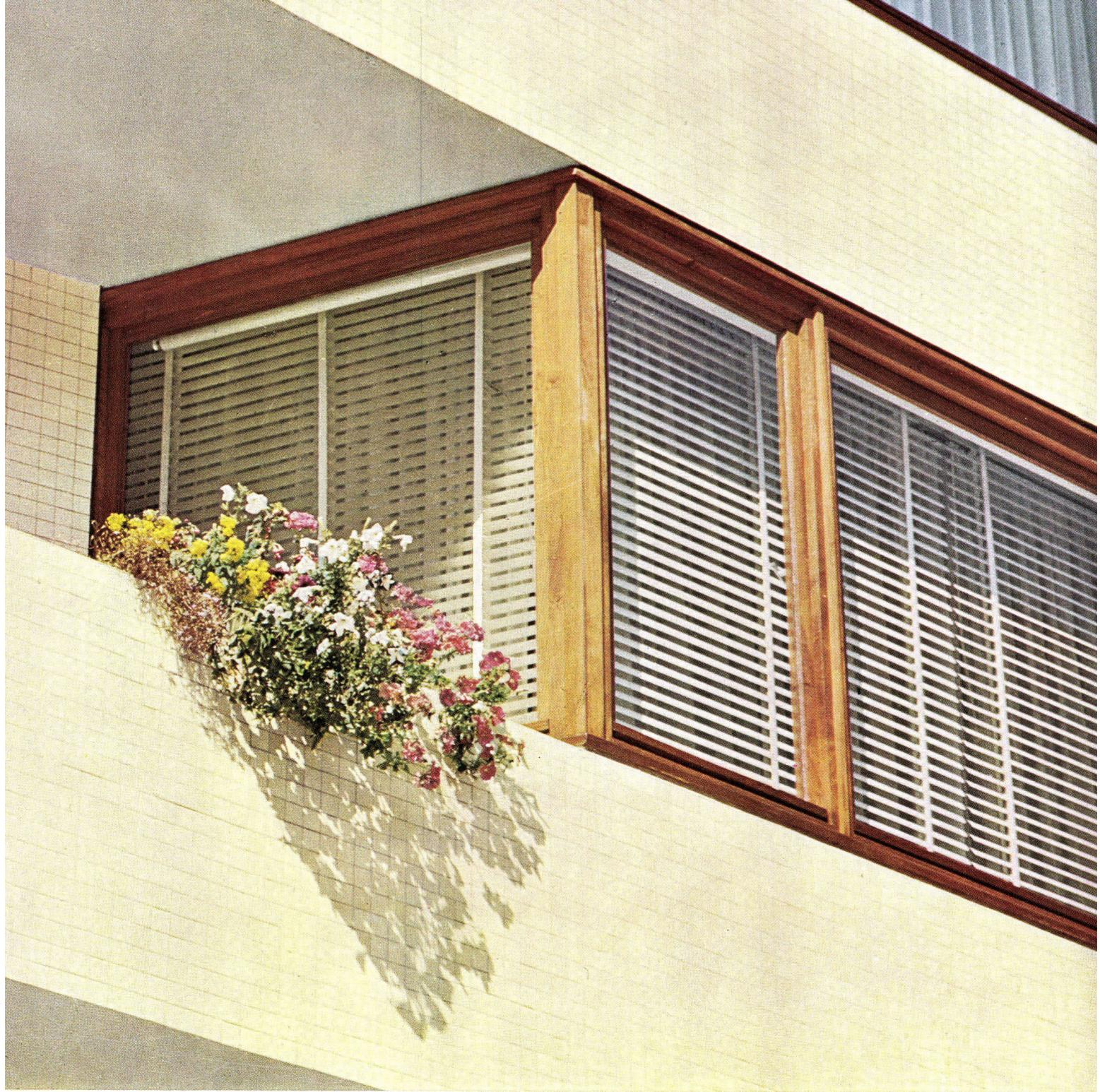
Fassadenverkleidung in Steinzeug-Mittelmosaik. Als Fassadenverkleidungen eignen sich Steinzeug-Bodenplatten und -Mosaik vorzüglich. Sie sind frostsicher, farbenfroh und müssen nicht erneuert werden.
