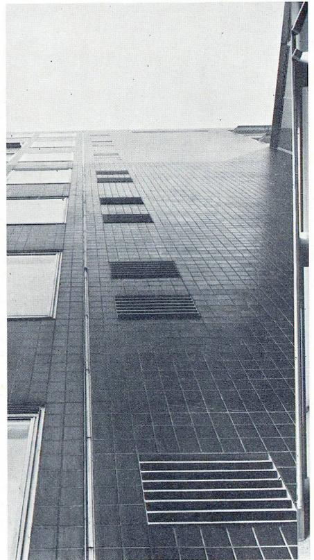
geschoßweise wie in jeder Fensterachse Kunststoffugen eingebracht, die eine Dehnung des Gebäudes durch Schwinden und Kriechen des Betons aufnehmen.
