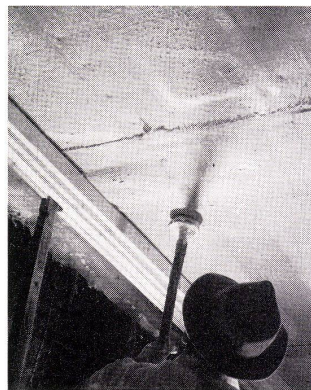
4 Dachisolierung – Aufschäumen von Griso-Spritzschaum zwischen Sparren auf die Schalung.
