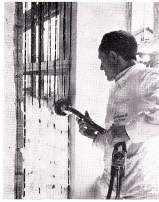
8 Schlitzisolierung – Griso-Spritzschaum wird durch Rippenstreckmetall gedrückt.
