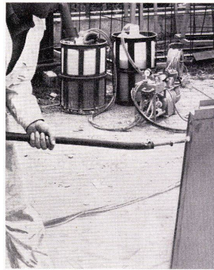
2 Isolation von Metalltüren mit Griso-Spritzschaum.
