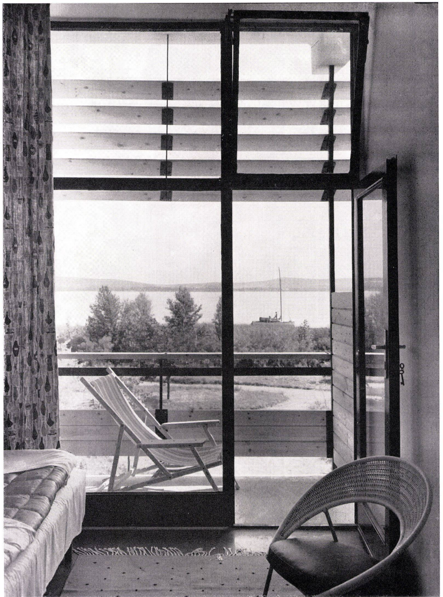
1 Gastzimmer. Die Sonnenlamellen sind verstellbar. Chambre d'hôtel. Les stores à lamelles peuvent être réglés. Guest room. The blinds are adjustable.
