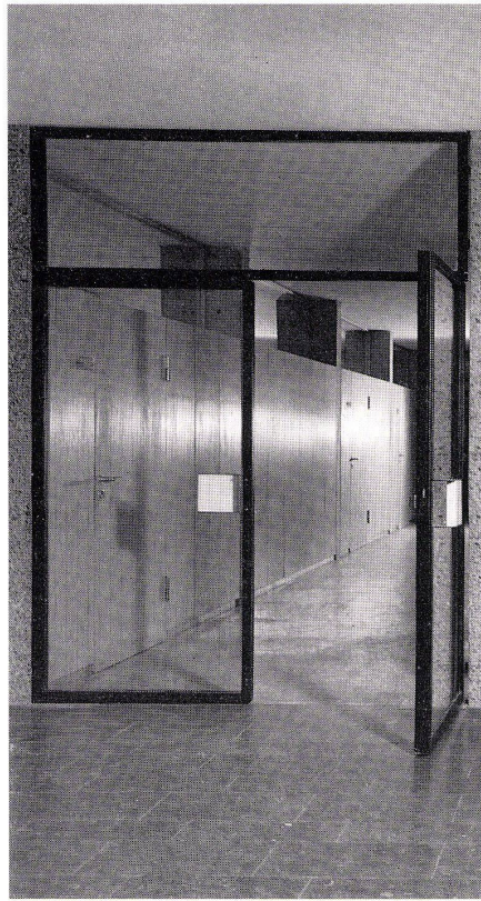
2 Blick vom Treppenvorplatz auf eine Flurwand, die über den eingestellten Schränken verglast ist. Treppenhauswand: gespritzter Beton, Boden: schwarze Beton-Werkstein-Platten. Vue depuis un palier sur un corridor. Paroi de l'escalier en béton. Revêtement du plancher en plaques de béton noires. Looking from access to stairs toward a passage wall, which is glassed above the closets. Stairwell wall: sprayed concrete. Floor: black concrete slabs. 3 Flurwand mit bis zur Decke reichenden Schränken (Limba-Holz), die zwischen die Innenstützen (Sichtbeton) gestellt sind. Parois d'armoires encastrées des corridors. Passage with closets (limba wood) reaching to ceiling, which are placed between the interior supports (raw concrete).
