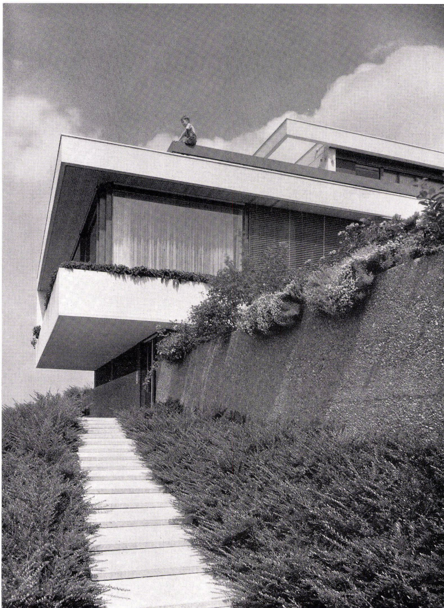
1 Blick auf das Haus von Südwesten her. Rechts Doppelgarage, daneben führt der Aufgang zum Gartengeschoß hinauf. Im auskragenden Teil das Wohnzimmer, darüber erscheint das Elternzimmer.
