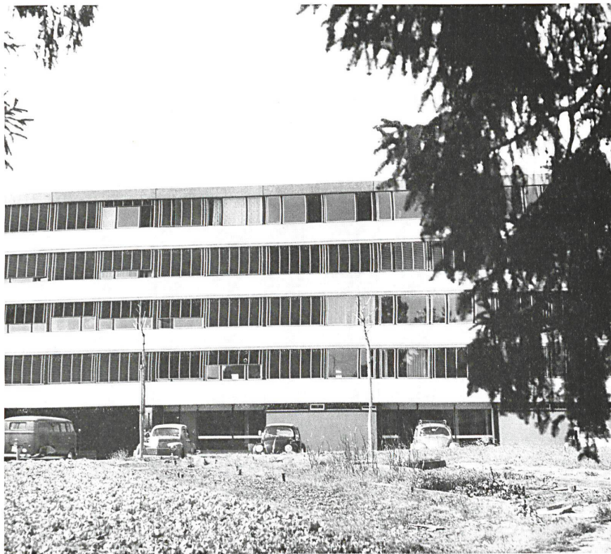
1 Fassadenausschnitt mit Südbalkonen. Détail de façade avec des balcons sud. Elevation detail showing south balconies.
