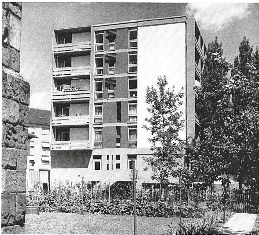
1 Südseite. Partie sud. South side.
