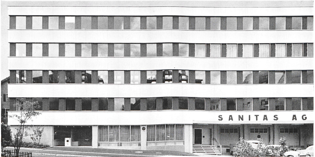
Eternitfassaden System Keller
