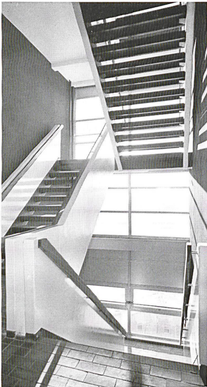
3 Treppen aus vorfabriziertem Stahlbeton. Escaliers en béton armé préfabriqué. Stairways in pre-fabricated reinforced concrete.
