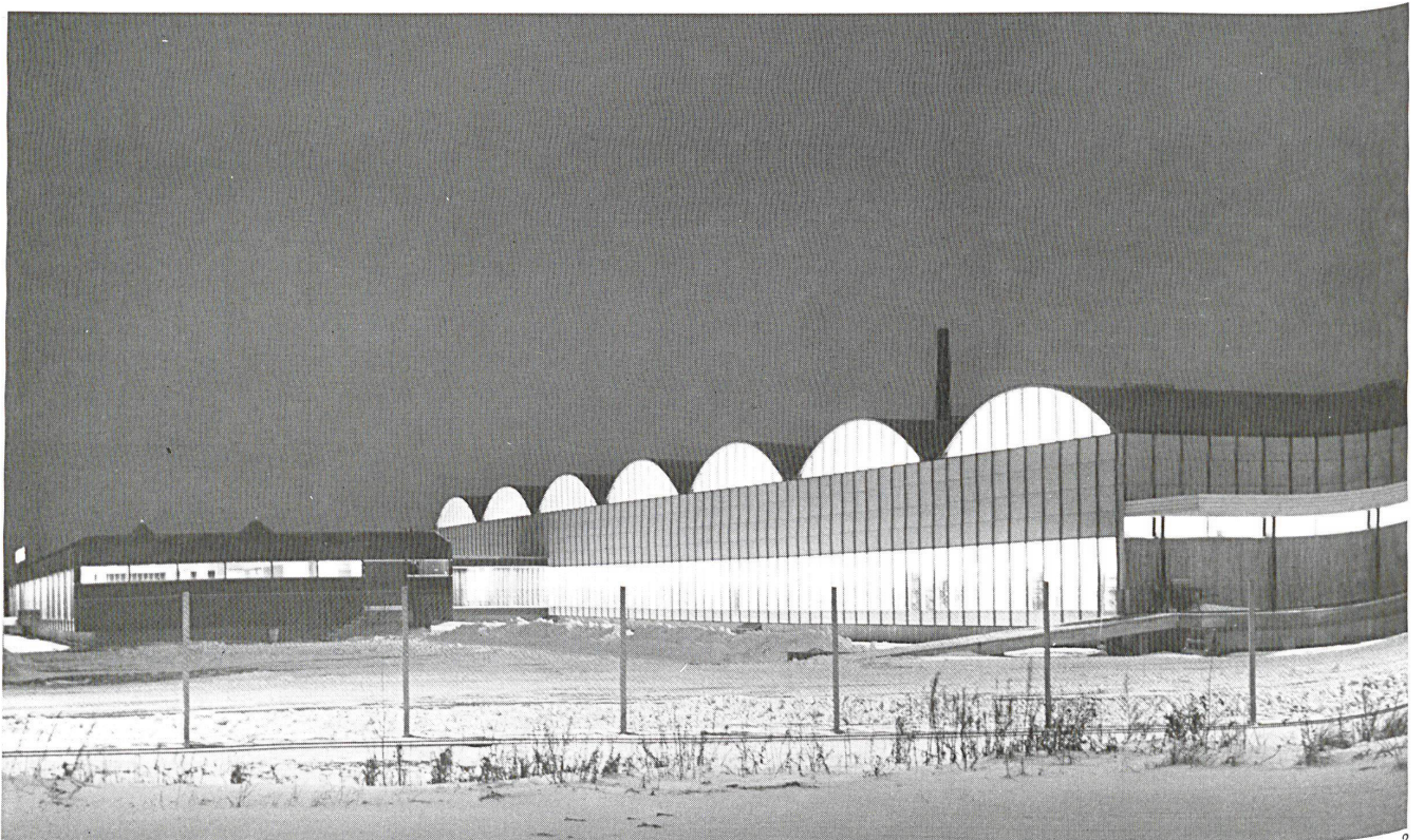
2 Nachtaufnahme des Bürogebäudes und der großen Fabrikationshalle. Prise de vue de nuit de l'immeuble de bureaux et de la grande halle de fabrication. Night view of office building and large production shed.
