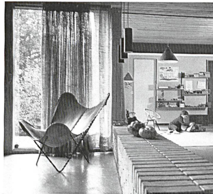
2 Das großräumige Wohnzimmer im Südflügel. Auch hier im wesentlichen nur zwei Baumaterialien, der gelbe Sichtbackstein und Holz an Wänden und Decke. Le séjour spacieux dans l'aile sud. Là aussi deux matériaux principaux: la brique jaune apparente et boisage pour les parois et le plafond. The spacious living room in the southern wing. Here again essentially only two building materials, yellow brick and wood on walls and ceiling.
