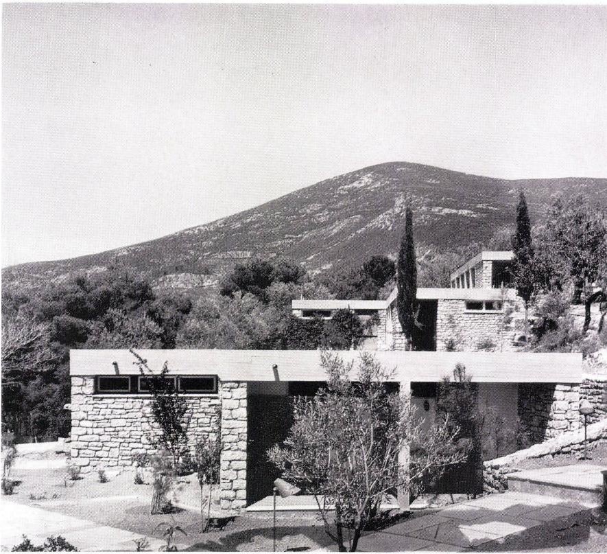
1 Vorn eines der Hotelhäuser mit zwei Loggias, hinten das Garderobengebäude. Devant, un des bâtiments «hôtel» avec deux loggias; derrière, le bâtiment vestiaire. In front, one of the hotel buildings with two loggias, in rear, the dressing-room building.
