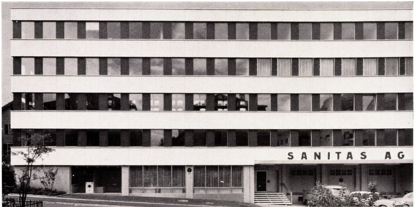
Eternitfassaden System Keller
