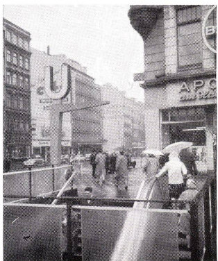
10 Fußgängertunnelanlage am Jahnplatz in Bielefeld. Die mit Fahrtreppen versehenen Ausgänge sind überdacht. 11 Wetterfeste Fahrtreppe im Regen: Ausgang Steindamm des Fußgängertunnels an der U-Bahn-Station Hauptbahnhof in Hamburg.
