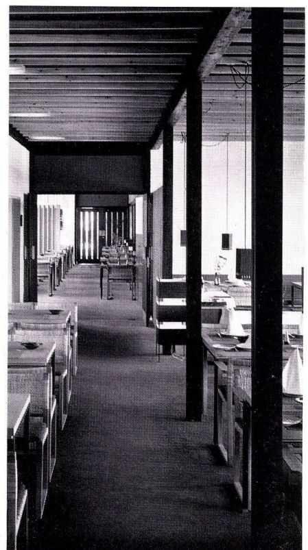
3 Wand zwischen Restaurant und Partyraum. Die Türflügel können hochgeklappt und an der Decke befestigt werden. Cloison séparant le restaurant des salons privées. Les battants peuvent être pivotés vers le haut et fixés au plafond. Wall between restaurant and party room. The leaves of the door can be folded up and fastened to the ceiling.
