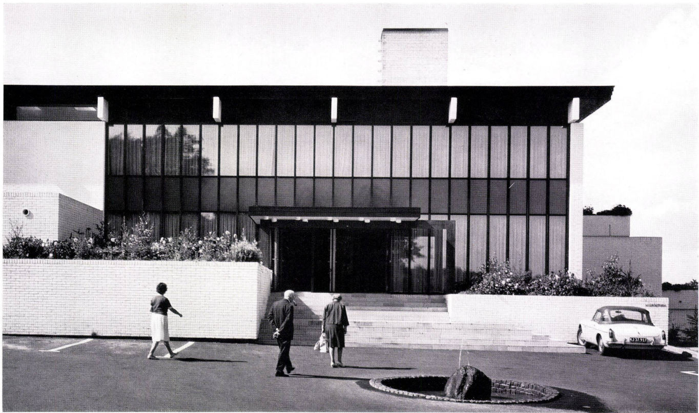
1 Haupteingang. Hinter dem großen Fenster die Rezeption. Entrée principale; derrière le grand vitrage se trouve la réception. Main entrance. Behind the big window the reception desk.
