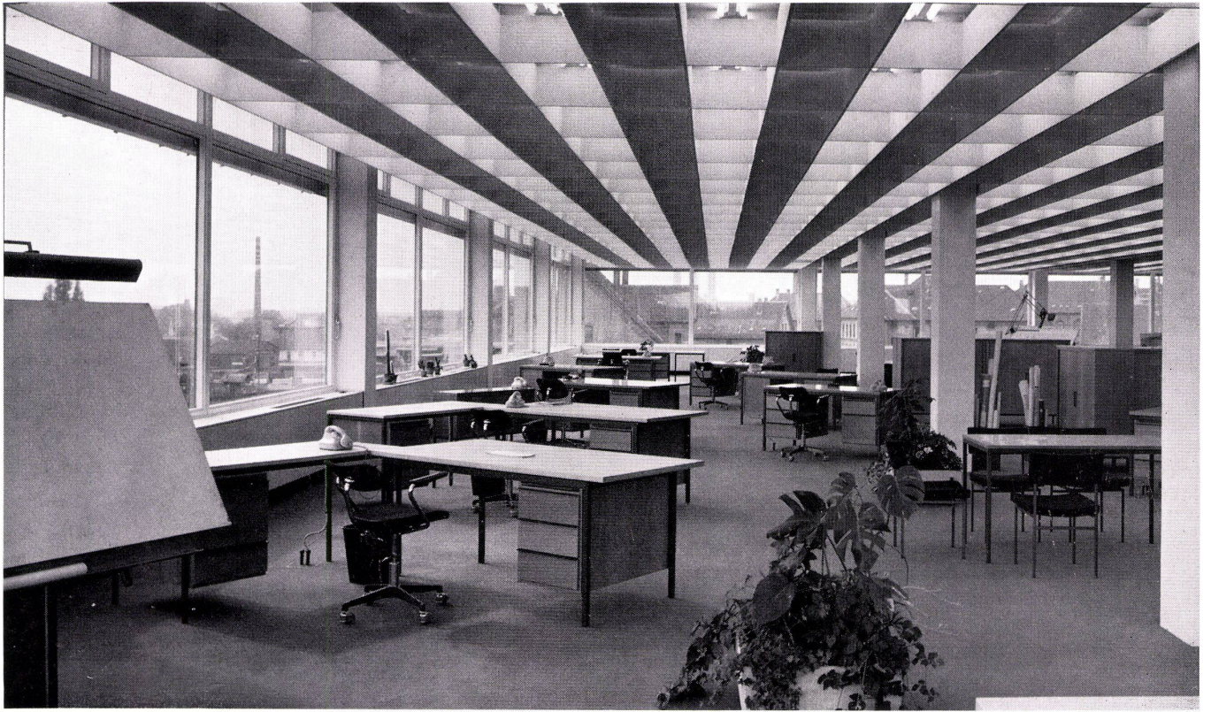
1 Blick in den Bürogroßraum des Betriebsgebäudes. Die untergehängte Decke besteht aus Akustikplatten. Vue vers le grand local de bureau de l'usine. Le pla- fond suspendu est composé de plaques isolantes. View of office tract in factory building, suspended ceiling clad with acoustic panels.
