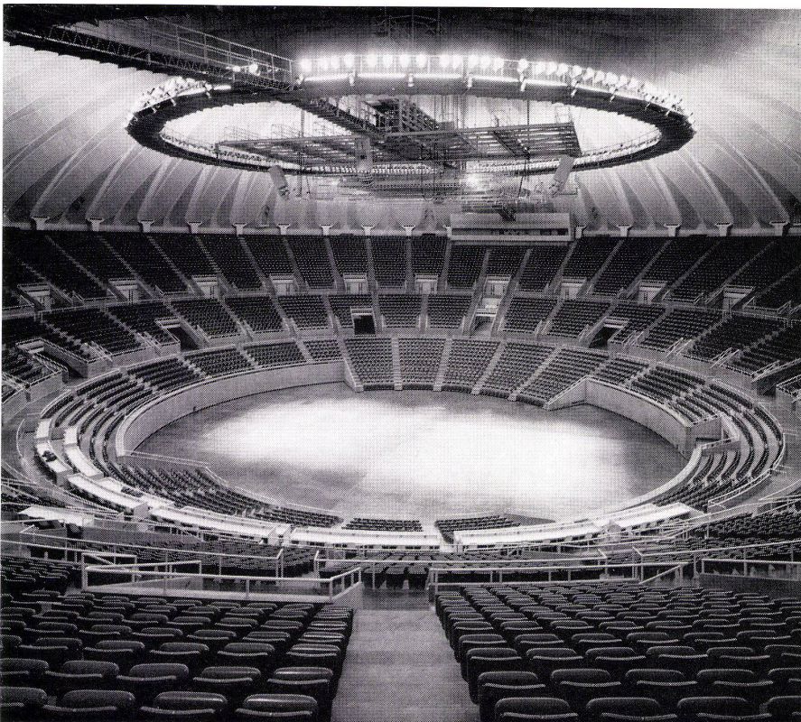
7 Innenansicht. Auf der gegenüberliegenden Seite der Projektionsstand. Oben Beleuchterbrücke mit Zugängen von zwei Seiten. Vue intérieure. Poste de projection sur le côté opposé. En haut pont de projection avec accès bilatéraux. Inside view. On the opposite side the projection stand. Above: Projection platform accessible from both sides.
