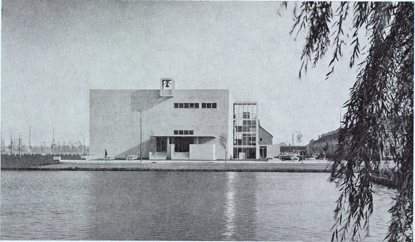
Blick auf die Wasserkirche von Nord- westen. Vue de l'église du nord-ouest. View of the church from northwest.
