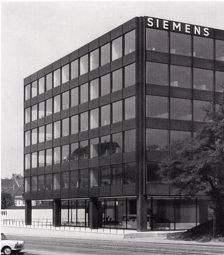
1 Geschoßbau, Ansicht von Südosten. Bâtiment à étages, vue du sud-est. High-rise building, view from southeast.
