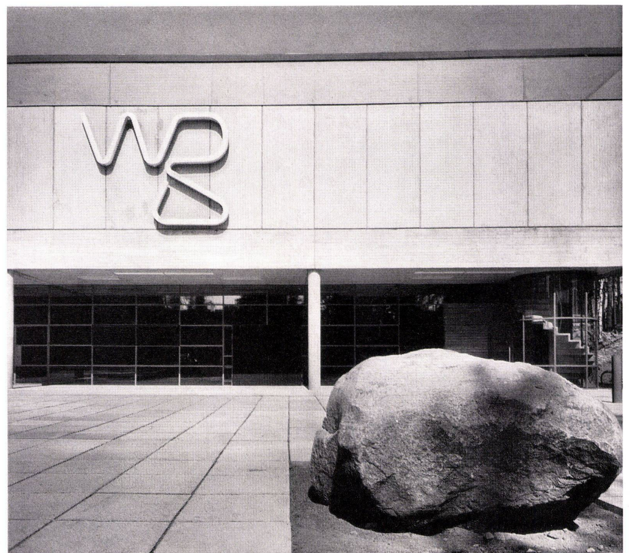
4 Eingang mit Firmenzeichen. Die Produktionshalle hat auf drei Seiten nur ein Fensterband unter der Decke. Entrée avec raison sociale. La halle de production n'a qu'une fenêtre sur trois côtés, sous la dalle supérieure. Entrance with firm designation. The production shed on three sides has only one window strip, under ceiling.
