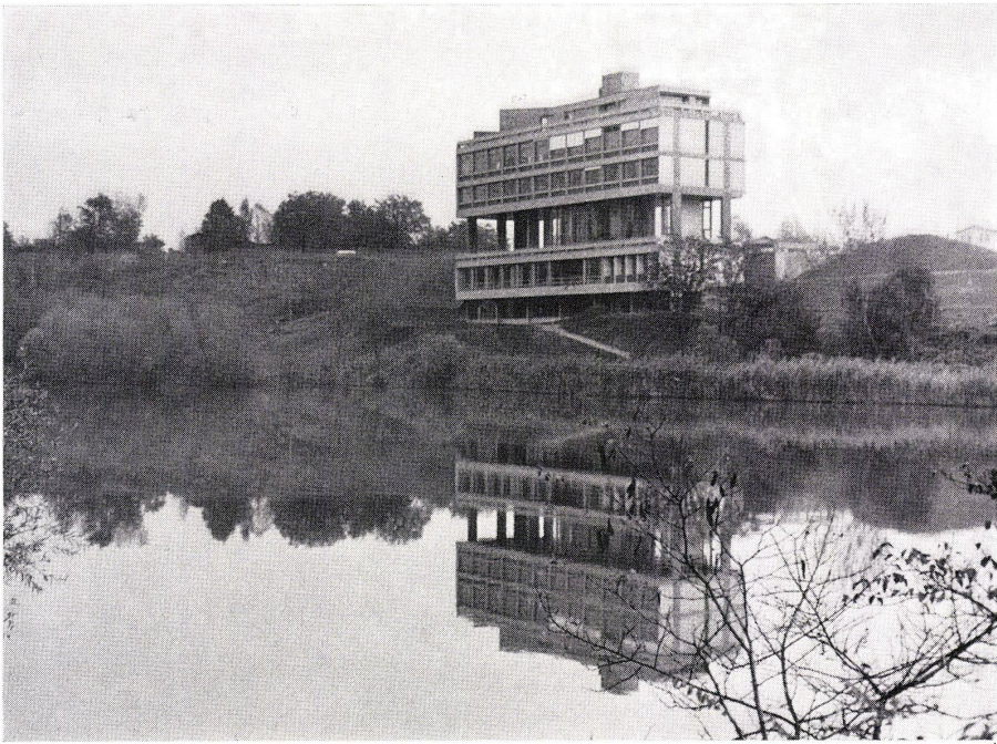
1-4 Dienstgebäude. Bâtiments de service. Service building.
