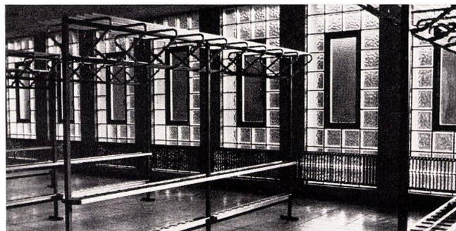
Glasbausteine bieten viel mehr Gestaltungsmöglichkeiten als die konventionelle Verglasungsart. Lichtstreuung, Isolation, Schalldämmung, Sicherheit gegen Feuer und Einbruch und dauernde Glasklarheit stempeln den Glasbaustein zum modernen exklusiven Bauelement.
