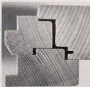
**1.** Druckausgeglichene äussere Falzzone und rundumlaufende Dichtungsebene
