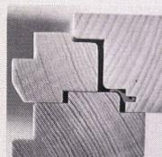
**5.** Zusätzlicher Einbau einer speziellen Falzdichtung
