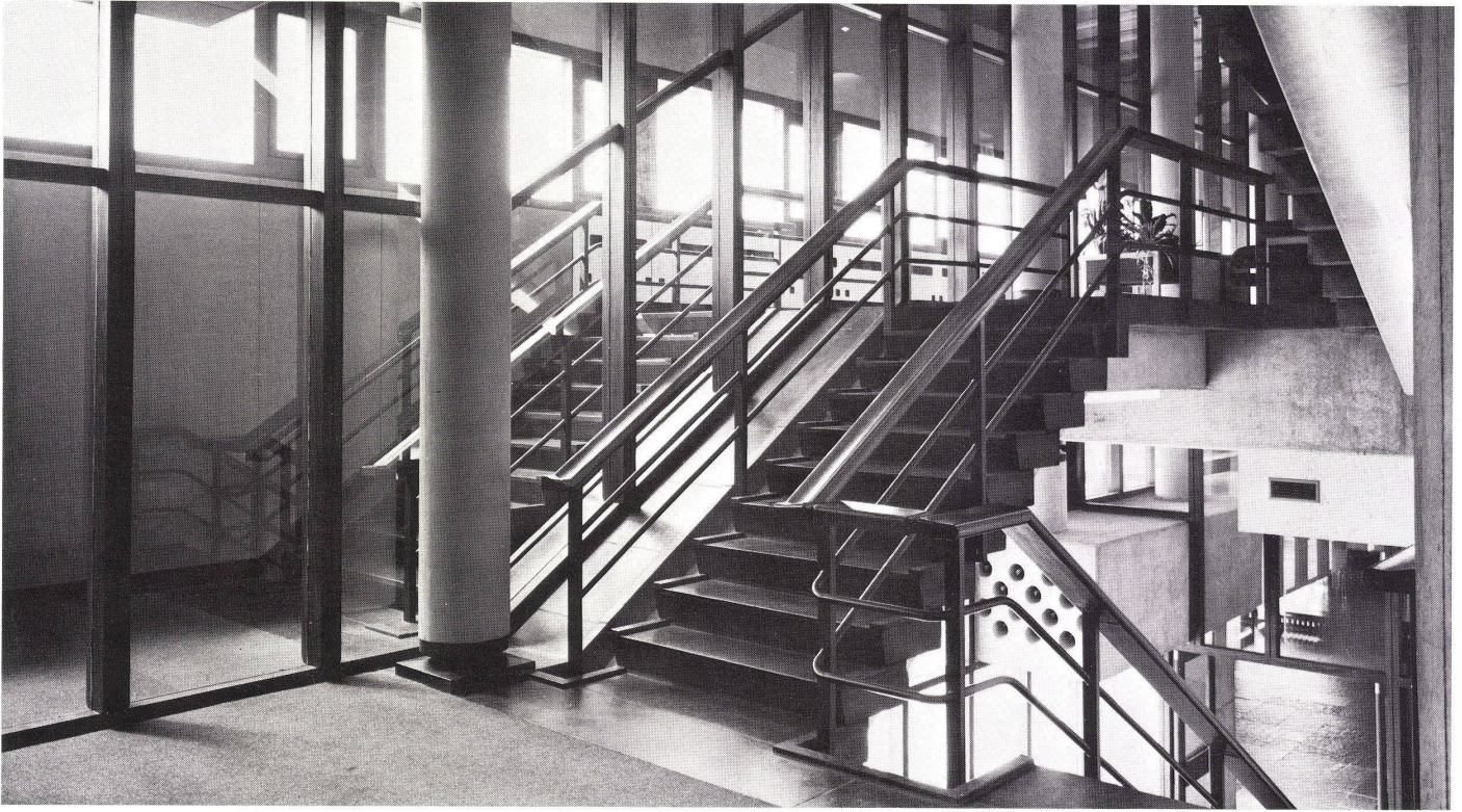
13 Halbgeschoß-Treppe. Escalier de liaison entre mi-niveau. Half-storey flight of stairs.
