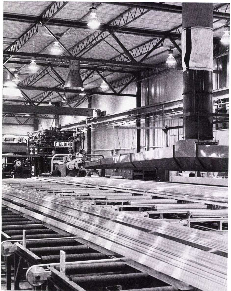
7, 8, 9 Innenansichten der Fabrikationshalle. Spannweite 21 m, Stützenabstand 10 m. Vues intérieures de la halle de fabrication. Portée 21 m. Entraxe des poteaux 10 m. Interior elevation views of the factory building. Span 21 m, support interval 10 m.
