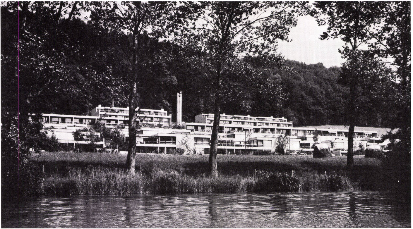
1 Gesamtansicht vom Wohlensee. Vue générale du lac de Wohlensee. Assembly view from the Wohlensee.
